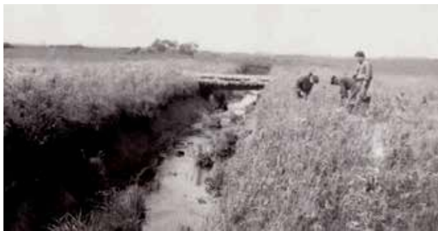
Рисунок 3. Мелиоративные работы на участке Новосондровской поймы
