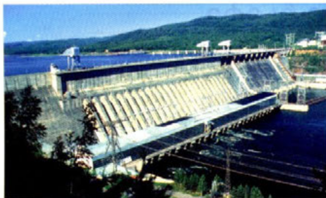
Рис. 2. Плотина Красноярской ГЭС
