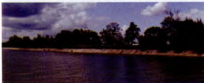
Рис. 14. Участок бетонной облицовки берега оз. Сенеж вдоль дороги
